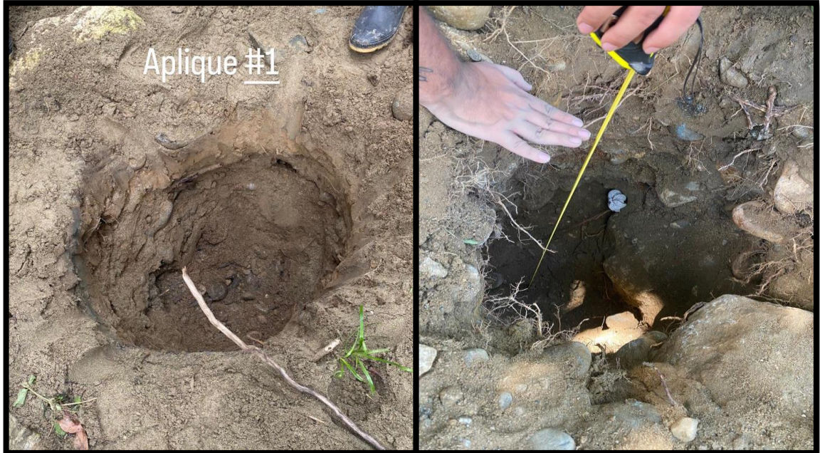
Figure 3. Apique realizado en el Área de estudio FUENTE: Autor
